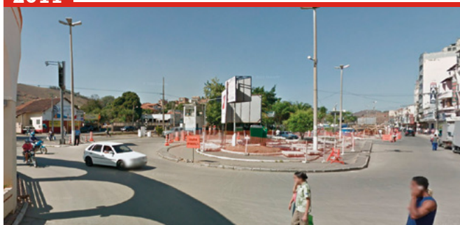
O viaduto da Avenida Condessa do Rio Novo estava em fase inicial de construção
